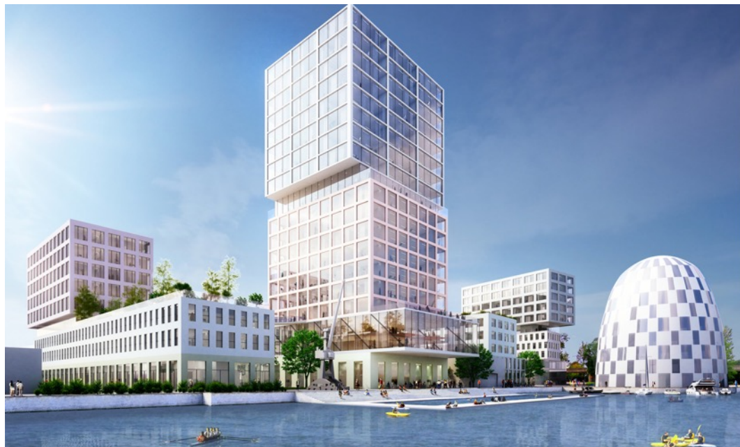
Nebenan: Hamburg Innovation Port mit Technischer Universität (im Bau)
